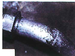
【例】クーラーパイプ補修
